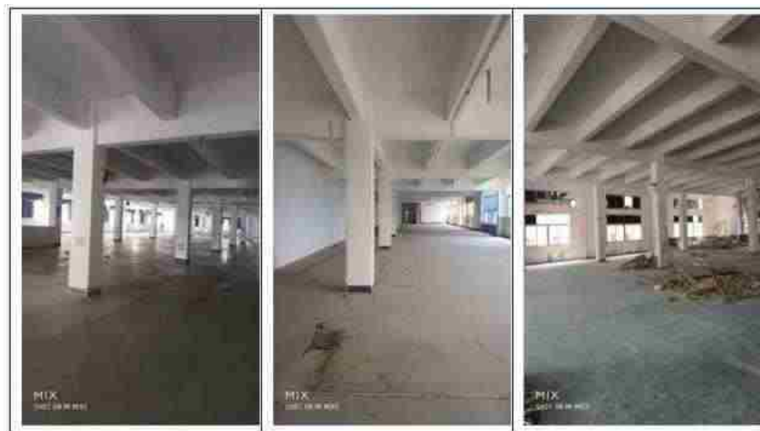
图8.2-6铭鑫华仓库内部现状
